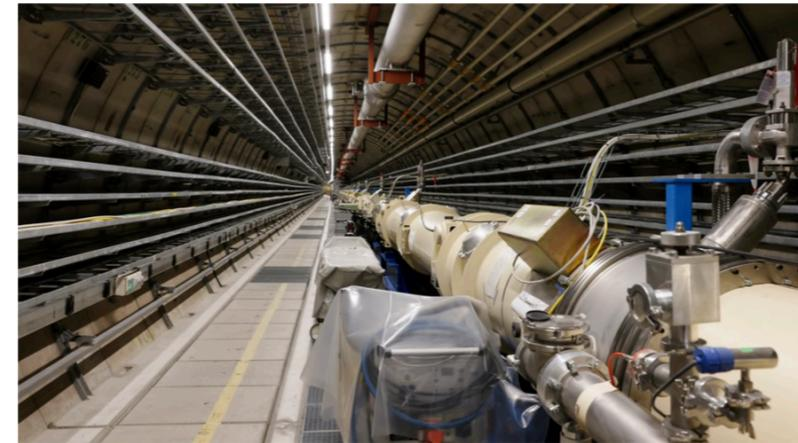
Blick in den DESY-Tunnel unterm Volkspark: Rechts die auf - 269 Grad gekühlte Röhre mit Magneten, durch die Laserlicht schießen wird
